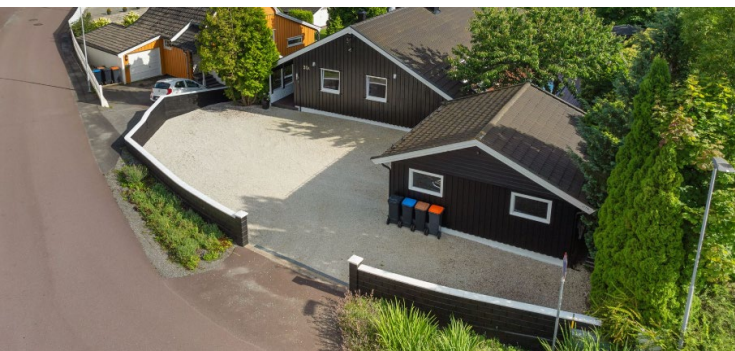
Stor innkjørsel med dobbelgarasje
